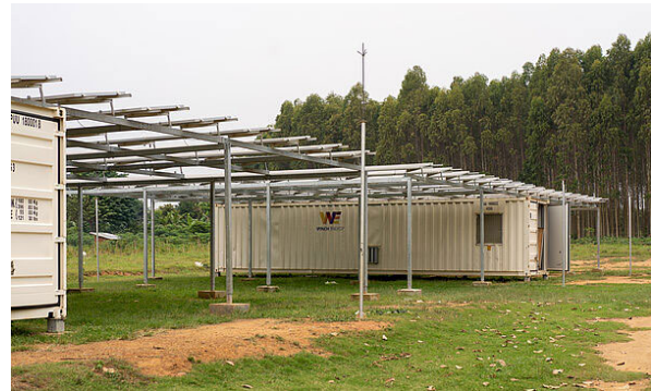
Abb. 14: Regenerative Energieerzeugung mittels PV und Akkumulatoren am Beispiel eines Projektpartners auf Bunjako Island (Foto: Stefan Krauter)
