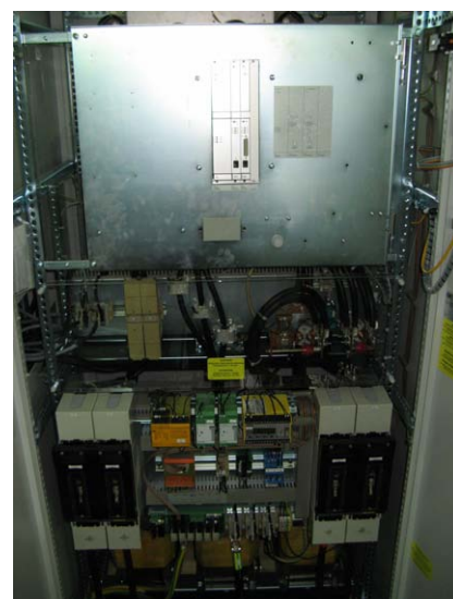
Bild 2: Ausgangsstufe der DC-Versorgung: DC/DC Steller zur Entkopplung der Zwischenkreise
